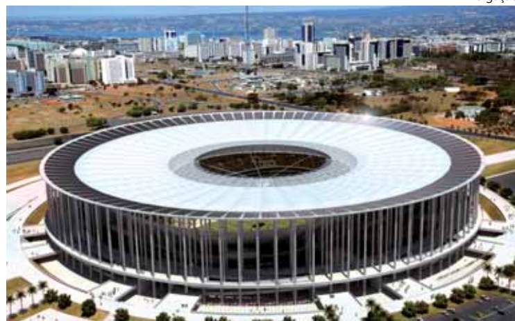
Projeto do Estádio Nacional Mané Garrincha, em Brasília: o primeiro no mundo a receber a certificação LEED Platinum
