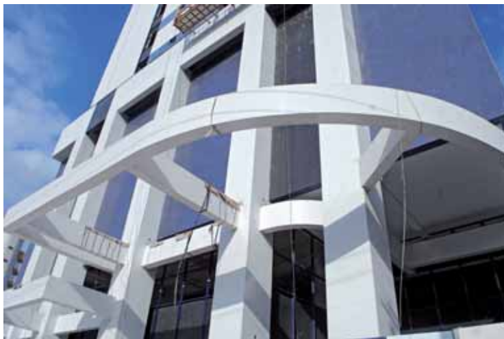
Detalhe da fachada do Unique Offices: plantas flexíveis
