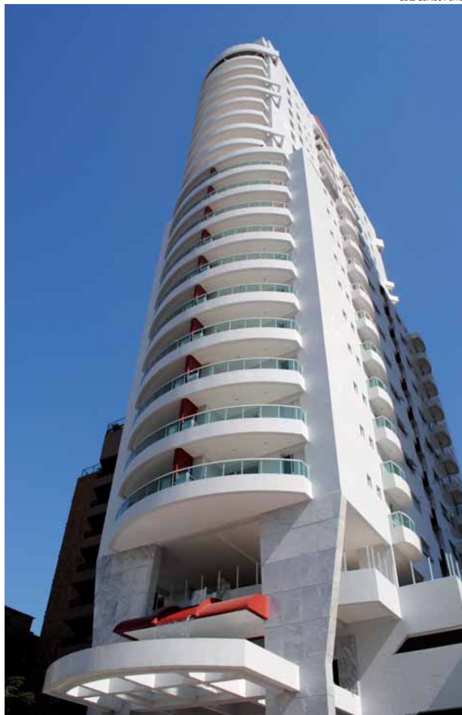
Torre toda revestida em pastilha de porcelana na cor branca, com cortinas de vidro e detalhes em mármore: linhas de tendência contemporânea
