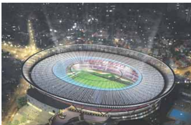
Morumbi: pendências na execução do projeto
