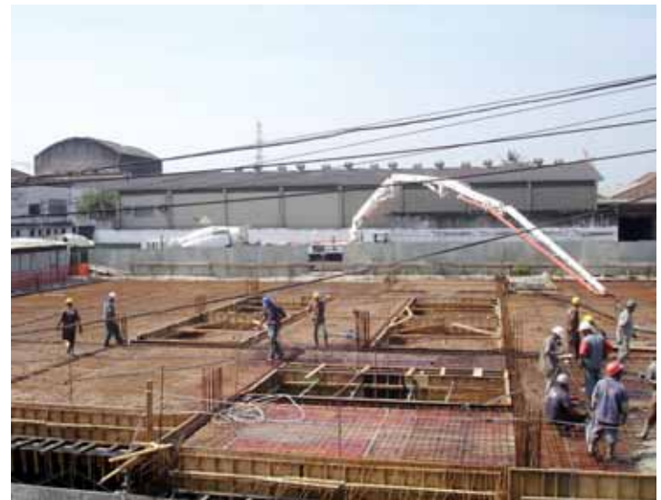
Concretagem de laje foi otimizada com utilização de bomba lança com alcance horizontal de 34,70 metros
