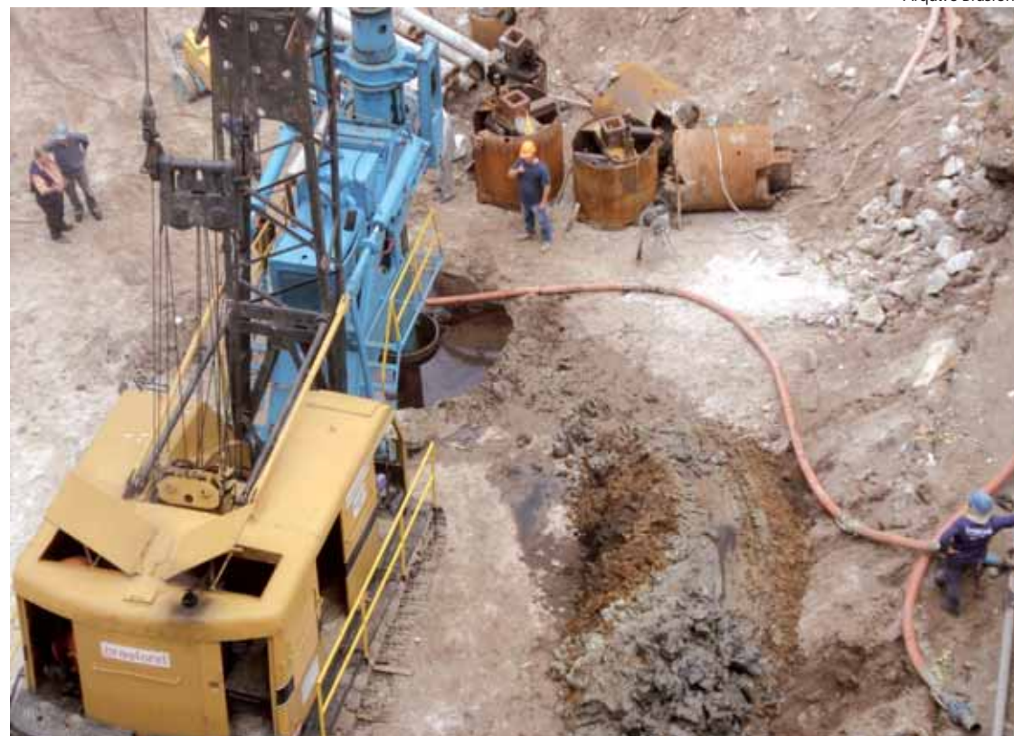
Cravação de estacas pela Brasfond: tecnologia utilizada na perfuração de poços de petróleo resultou na conquista de 'selo verde', com certificado do Ibama
