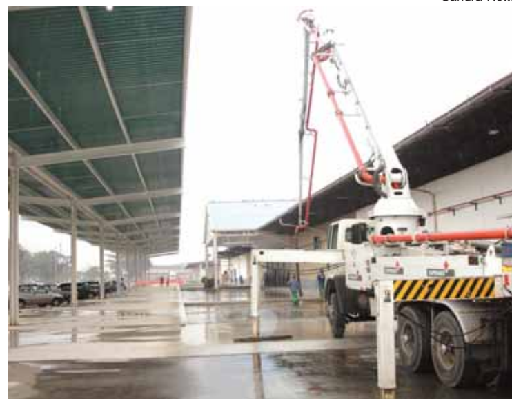
Terminal Marítimo: bomba de alta pressão agilizou trabalhos
