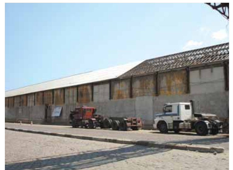
Serviços de alvenaria, como o fechamento dos armazéns, com bloco estrutural; no telhado, uso de telha de fibrocimento
